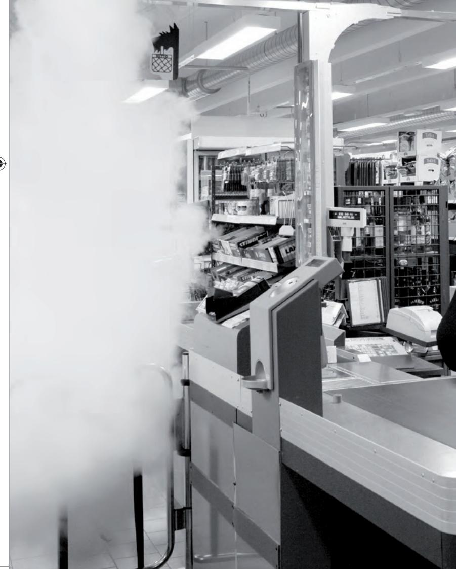
*Un Canon à Brouillard PROTECT™ remplit une pièce avec un brouillard épais en quelques secondes, ce qui rend impossible de voir sa main devant son visage. Votre installateur d'alarme doit se baser sur la taille de la pièce et sur sa disposition afin d'évaluer le nombre de canons à brouillard nécessaires pour une protection optimale de vos objets de valeur.*
